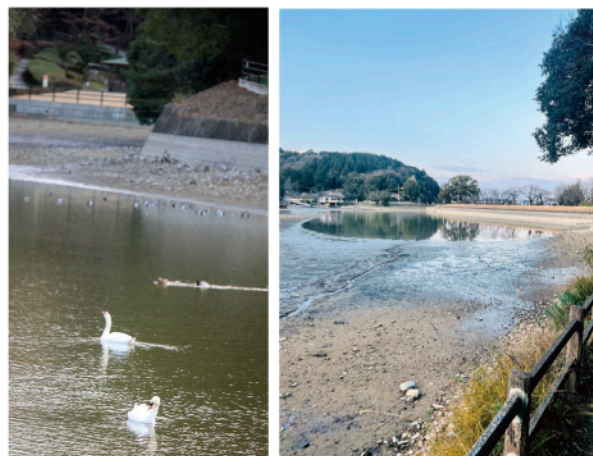
▲市民の憩いの場、滝の宮公園の大池が工事で水がなくなっている現在
