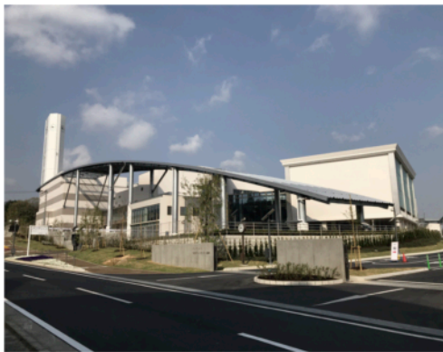
▲最先端のごみ処理施設「バリクリン」が4月から本稼働
